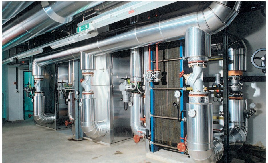
Wärme aus dem Boden: Mit 16 Kilometern Länge und 260 angeschlossenen Häusern ist der Wärmeverbund «Riehen plus» schweizweit wegweisend für eine nachhaltige Energieversorgung. (Bilder: zvg)
