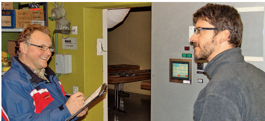
Stefan Zimmerli (links) von der Gemeinde Stans und Adrian Weitnauer vor dem Schaltschrank mit dem neu eingebauten Hygromir. (Bilder: zvg)
