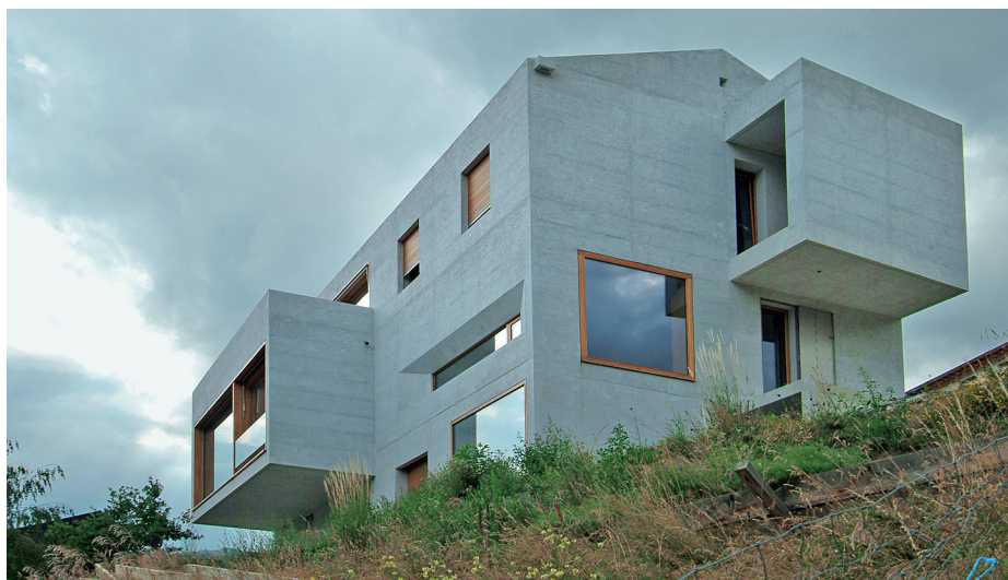
Ein Haus aus Misapor-Beton: Dank der Beimischung von Schaumglasschotter, hergestellt aus Altglas, verfügt der Beton über gute Dämmwerte. (Bild: Misapor AG)
