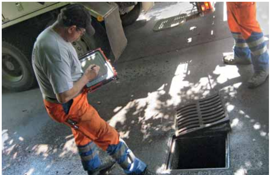
Konkrete GIS-Anwendung in der Stadt Bern: Das Tiefbauamt bewirtschaftet die Schlammsammler und dokumentiert deren Zustand über ein GPS-gestütztes System. (Bilder: Vermessungsamt Stadt Bern)
