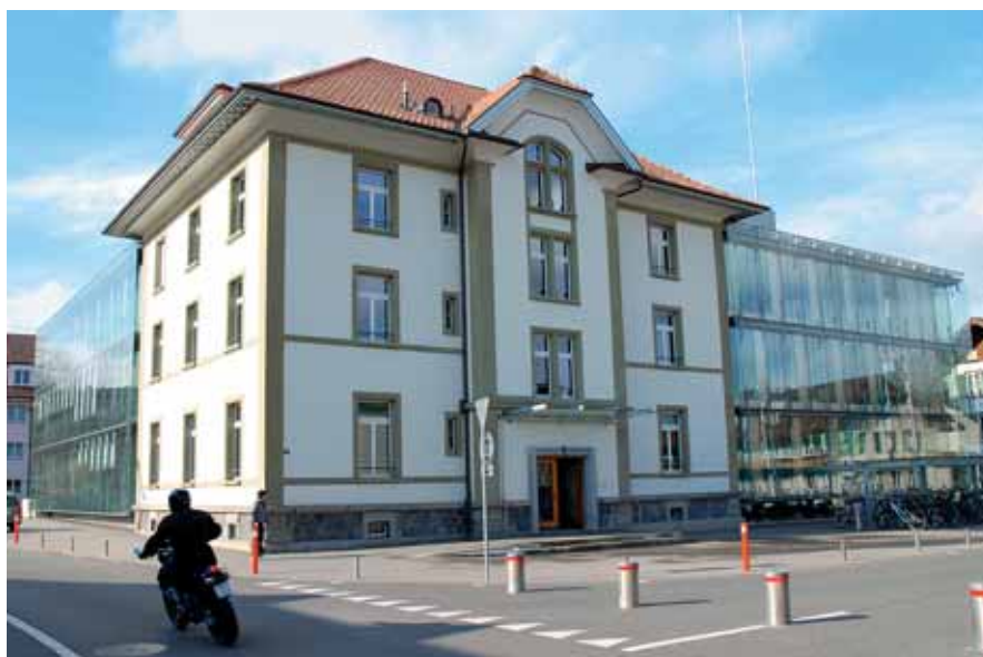
Das 2004 eingeweihte Verwaltungsgebäude in Köniz ist eine Synergie von Alt und Neu. (Bilder: Miryam Azer)
