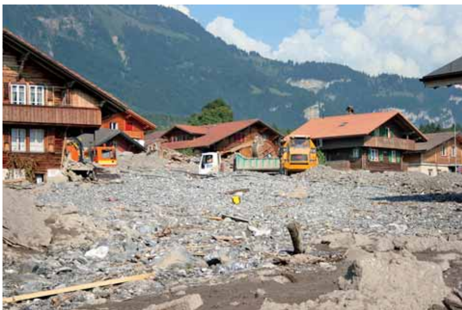
Bei den Räumungsarbeiten hat die Gemeinde sehr schnell und richtig entschieden, was bei der Abrechnung vieles einfacher machte.
